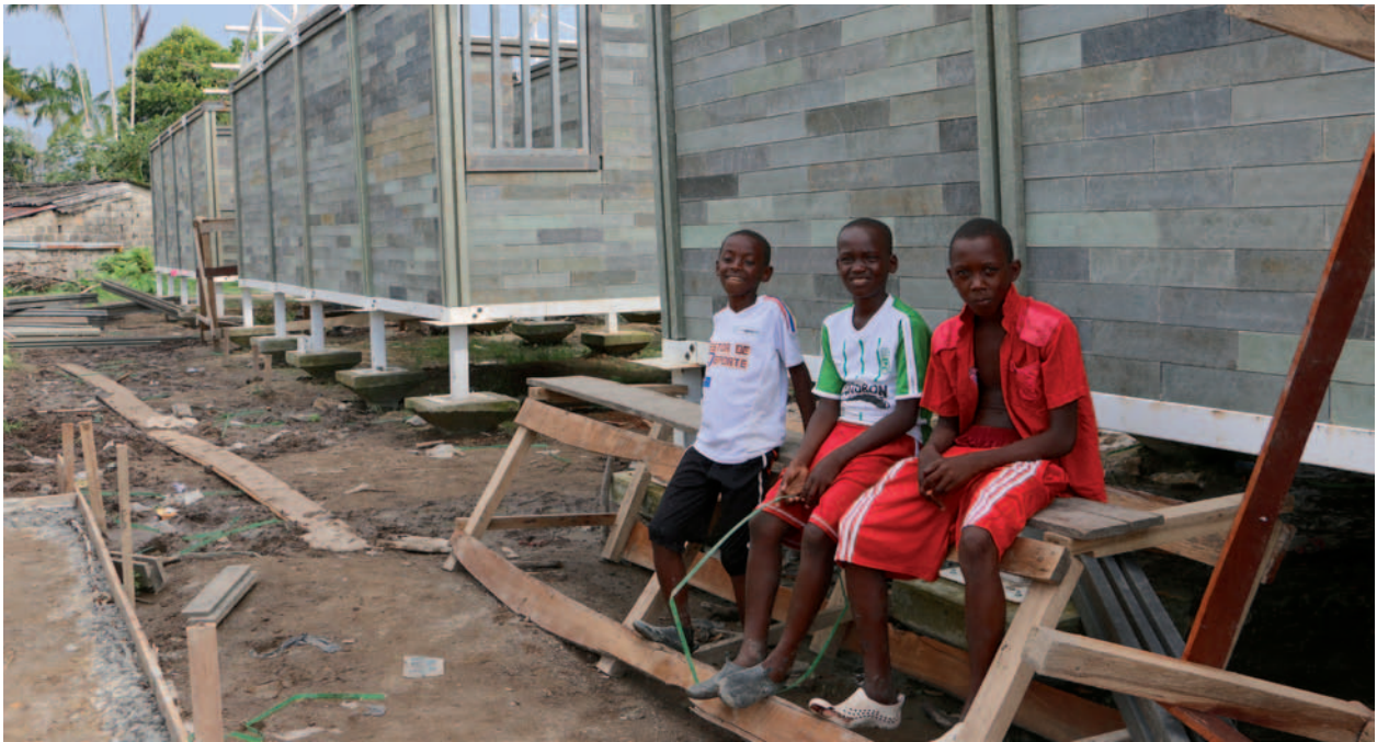
NRC a construit des abris mobiles pour les personnes déplacées du Cauca, Colombie. NRC/Marcela Olarte, 2015
